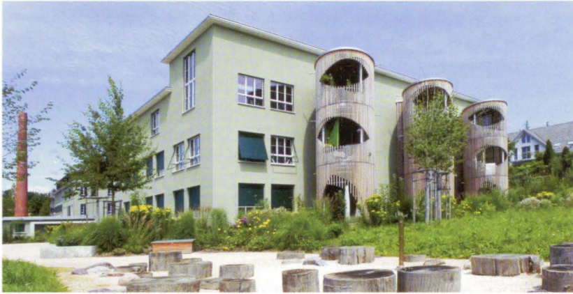
Die markante Fassade blieb erhalten und wurde mit luftigen Loggiatürmen ergänzt.
