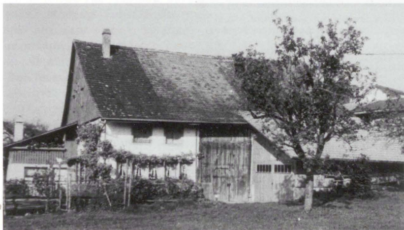
Blick von der Hardstrasse auf den Wohnteil mit der Sonntagsstube und den schönen Bauerngarten.
