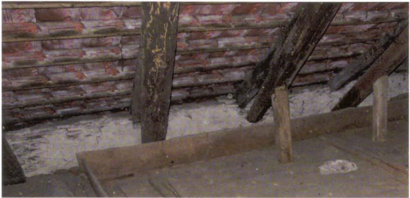
Kornschütte auf dem Windenboden. Darüber sind die Dachsparren für das Knickdach gut sichtbar.
