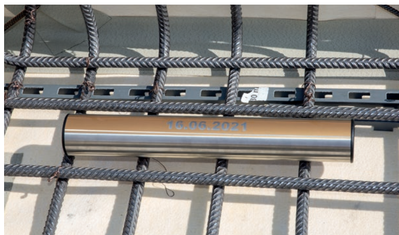
Die Zeitkapsel mit Dokumenten und Glücksbringern wurde einbetoniert.
